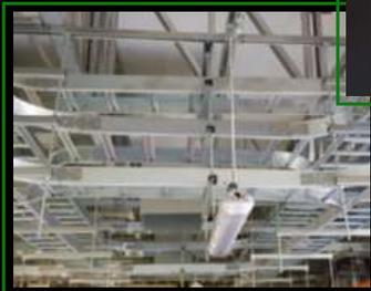
INSTALACIÓN DE ESCALERILLAS Y BANDEJAS PANDUIT PARA FO, CLIENTE TELEFÓNICA, INDEPENDENCIA, SANTIAGO.
